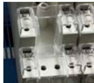
Frånskilningsdon 400A
