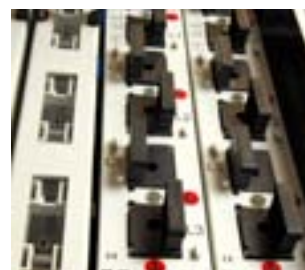
Säkringslastfrånskiljare 63A-400A
